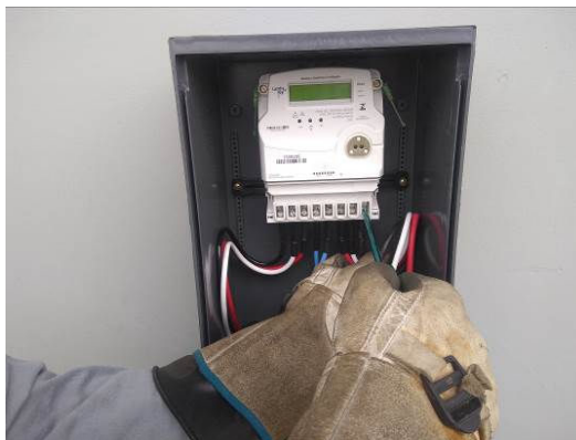
Figura 3 – Retirada do condutor de saída
