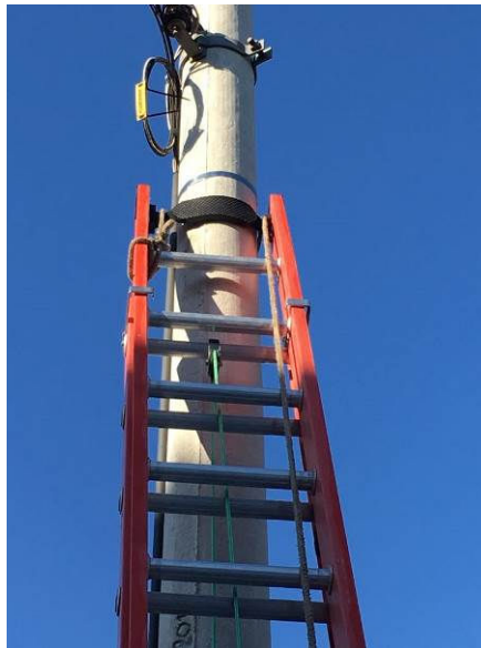
Figura 23 – Posicionamento da escada
