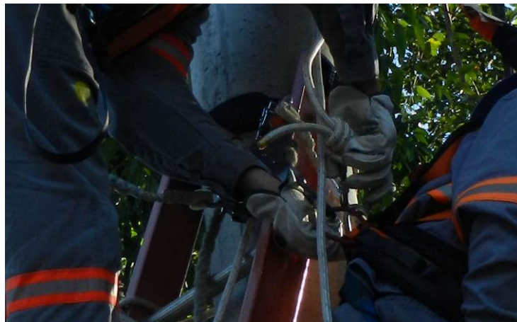
Figura 49 – Engate do mosquetão no trava-quedas do acidentado
