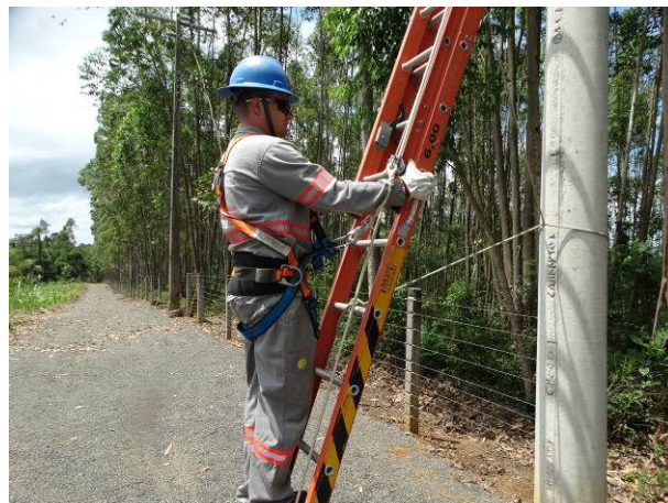
Figura 37 – Subida na escada
