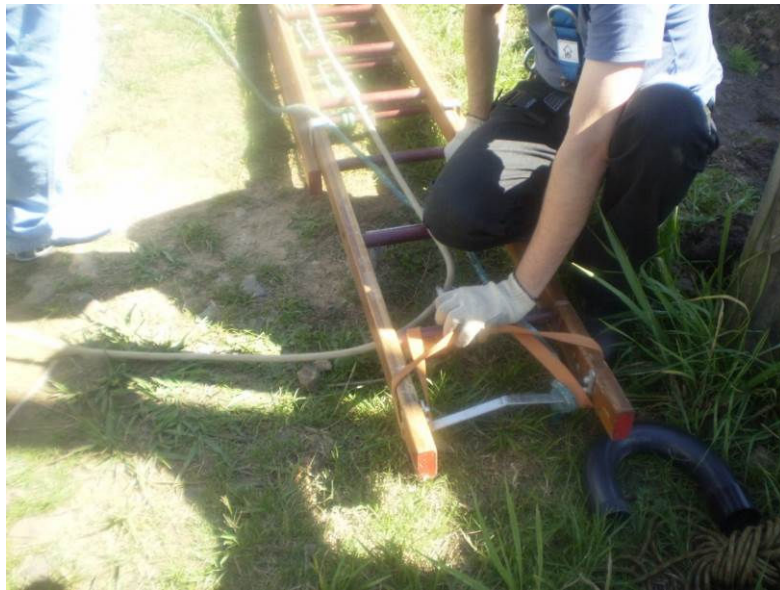
Figura 13 – Instalação da linha de vida
