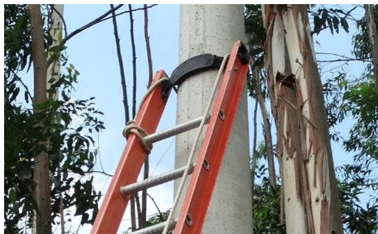
Figura 22 – Posicionamento da escada
