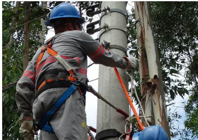
Figura 48 – Fixação do ponto de ancoragem
