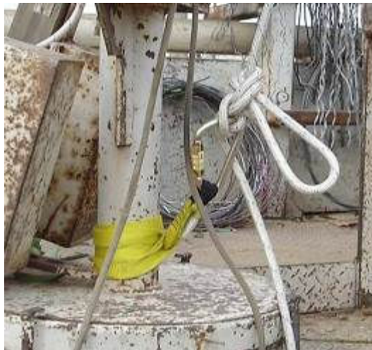
Figura 11 – Ponto de ancoragem
