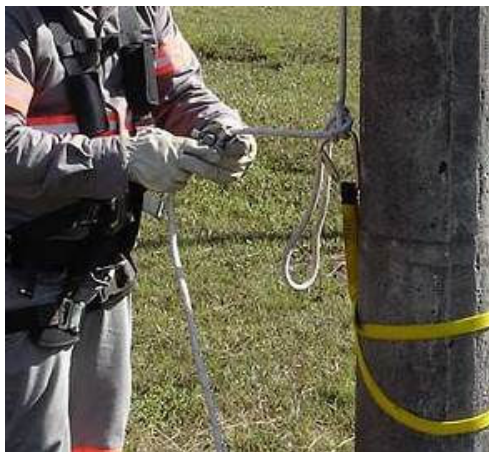
Figura 39 – Instalação do trava-quedas
