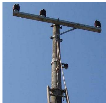
Figura 17 – Ancoragem na ferragem do poste
